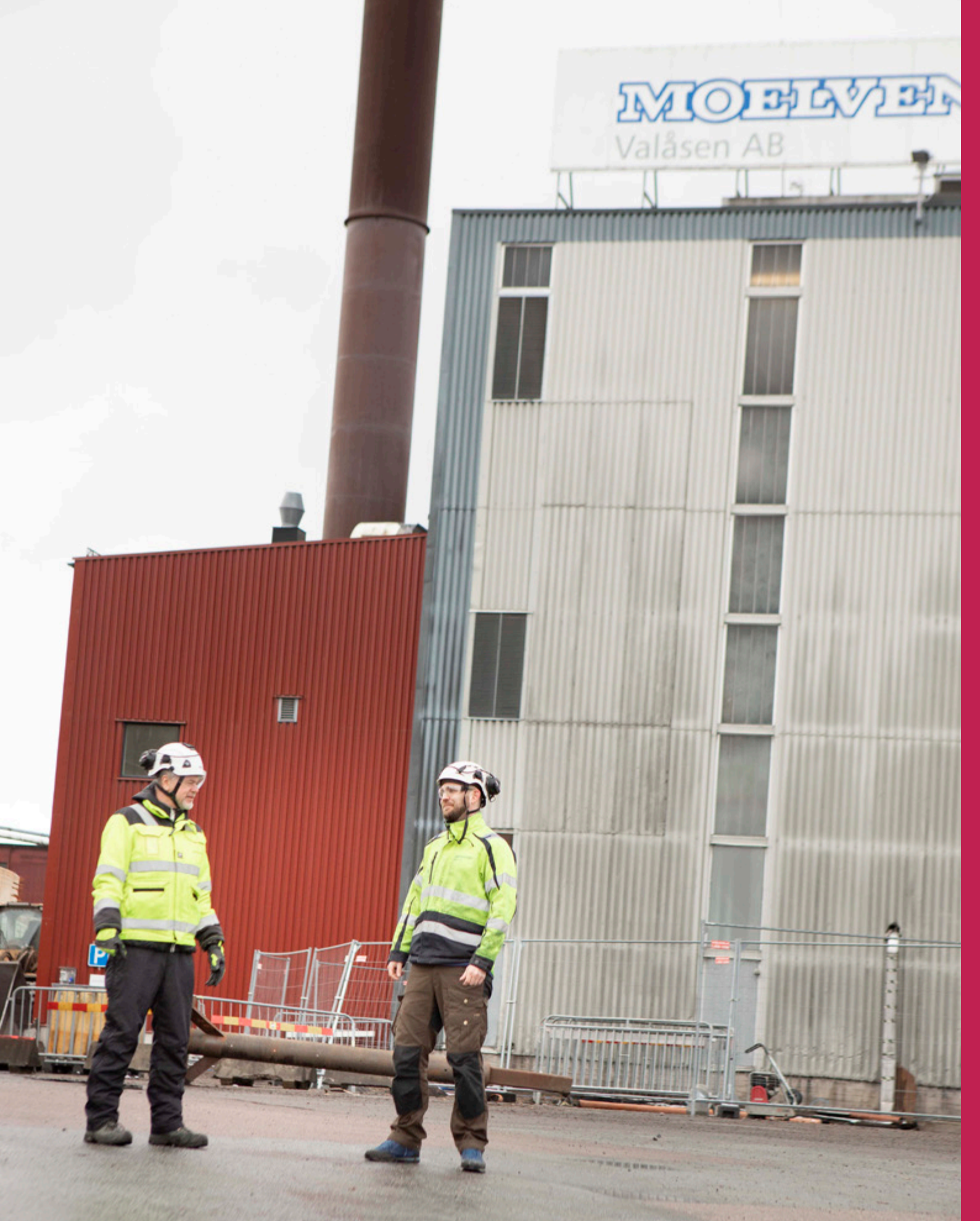
Patrik Svensson och Peter Rockedahl framför platsen där den nya energicentralen på Moelven Valåsen AB ska byggas. Med den tillgodoser företaget sitt framtida energibehov på ett hållbart sätt.
