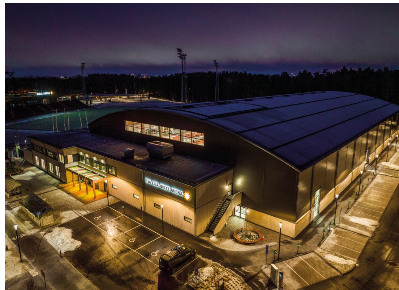
Helt nya Eva Lisa Holtz Arena i Karlstad består av flera Moelven-produkter. Moelven Töreboda AB har levererat limträ och KL-trä till arenan medan Moelven Wood AB står för den yttre fasaden. Foto: Sören Håkanlind
