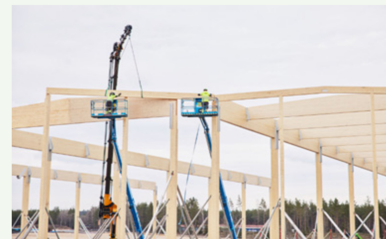
Elgigantens nye lager- og logistikkanlegg i Jönköping blir et av Nordens største. Moelvns leveranse består av over 500 saltaksbjelker, og de er 24 meter lange og nesten to meter høye. Den bærende konstruksjonen i det 86 000 kvadratmeter store bygget består i sin helhet av limtre fra Moelven Töreboda AB og Moelven Limtre AS. Foto: Sören Håkanlind og Jonas Ingman
