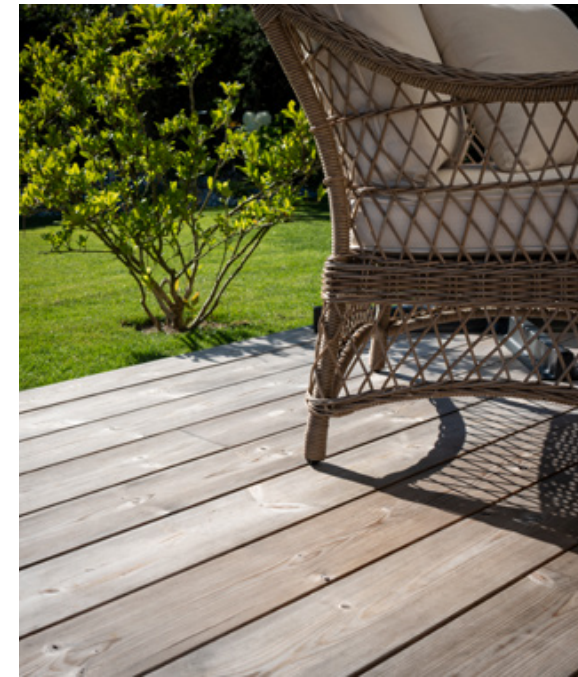
Termofuru, grønn plen, fine utemøbler og planter i flott harmoni. Terrassebordene er montert perfekt med skjult innfesting.
